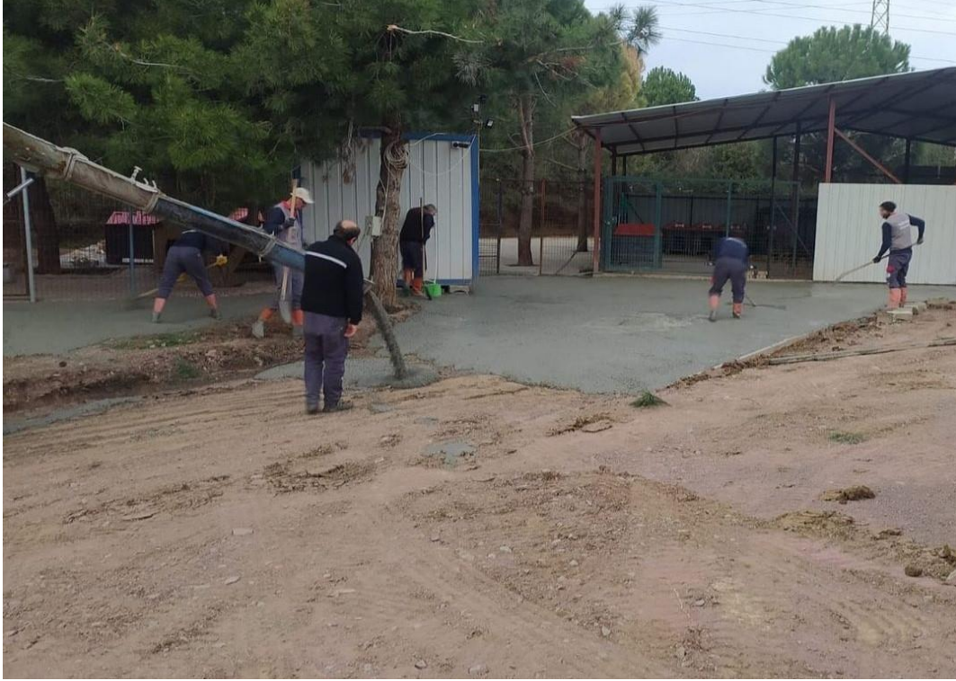
Hayvan barınađımızda beton alıřması yapıldı.
