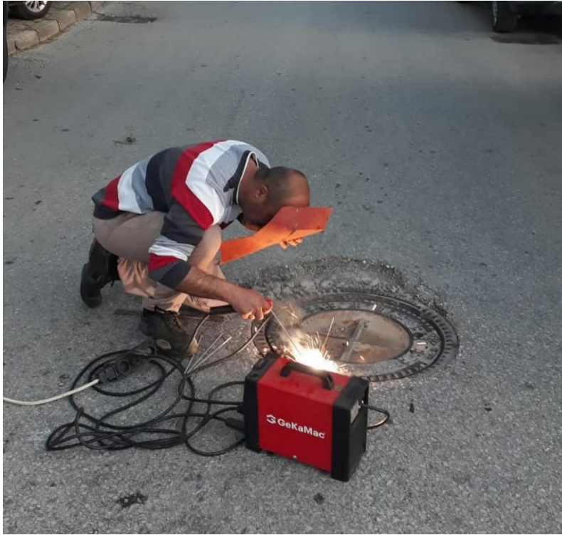
Çevre güvenliđini korumak amacıyla rögar kapaklarının kaynak işlemleri yapılarak sabitlenmesi sağlandı.
