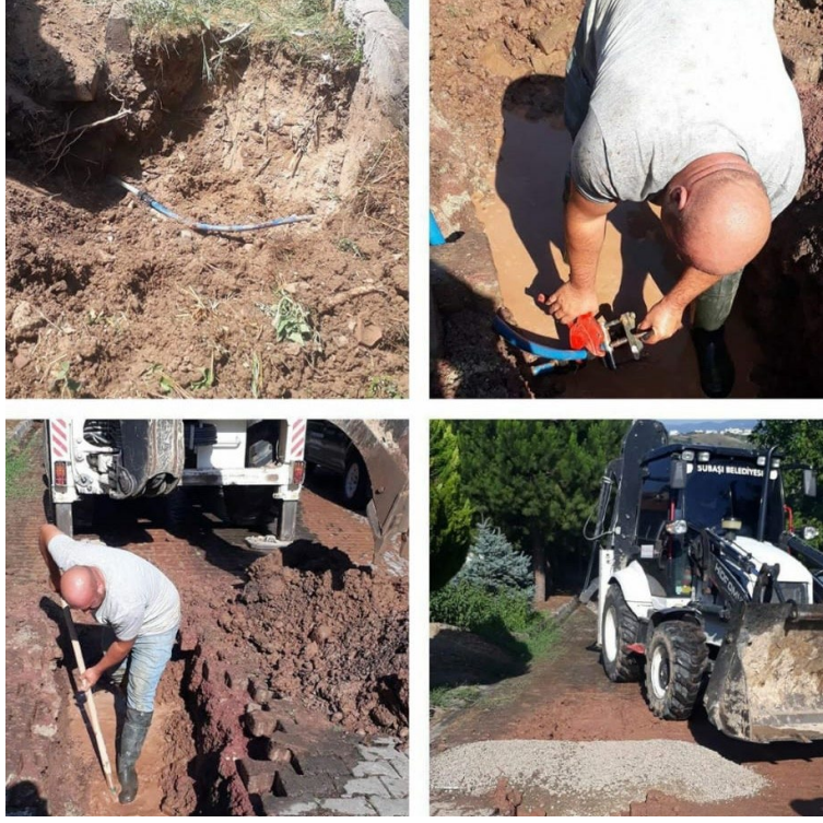
Merkez Mahallesi 27/20. Sokaklarda meydana gelen su patlakları onarıldı.
