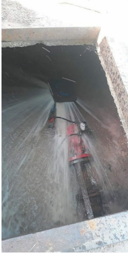
Basınç kırıcılar sayesinde 116-118. sokaklardaki su arızası giderildi.
