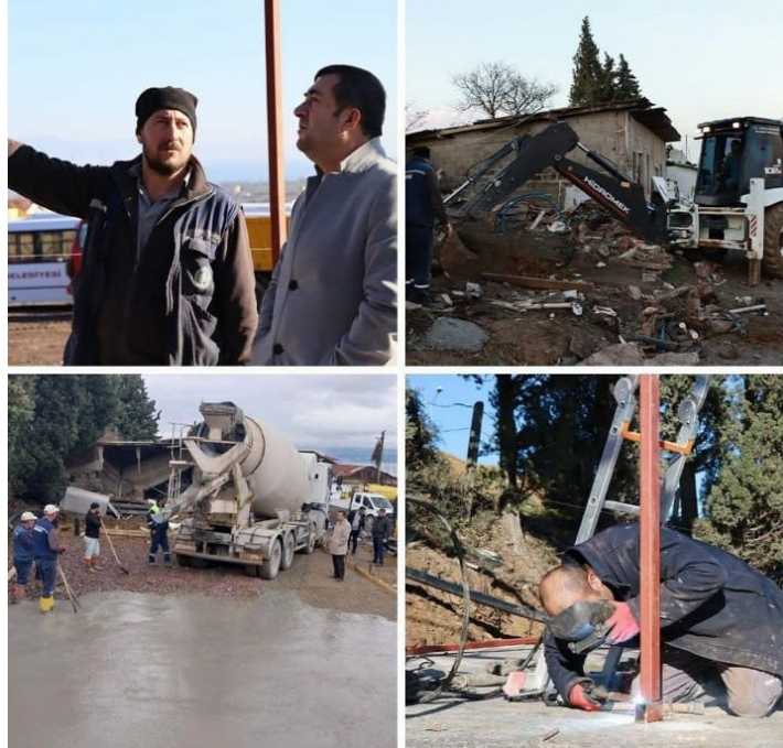
Garaj Amirliğimizde bulunan ömrünü tamamlamış atölye odaları, depo ve dinlenme alanlarının yıkımına başlandı.
