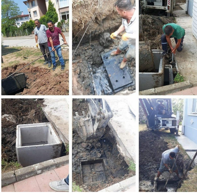
99. Sokak ve 101. Sokaktaki kanalizasyon baca yükseltme-temizlik çalışmaları tamamlandı.
