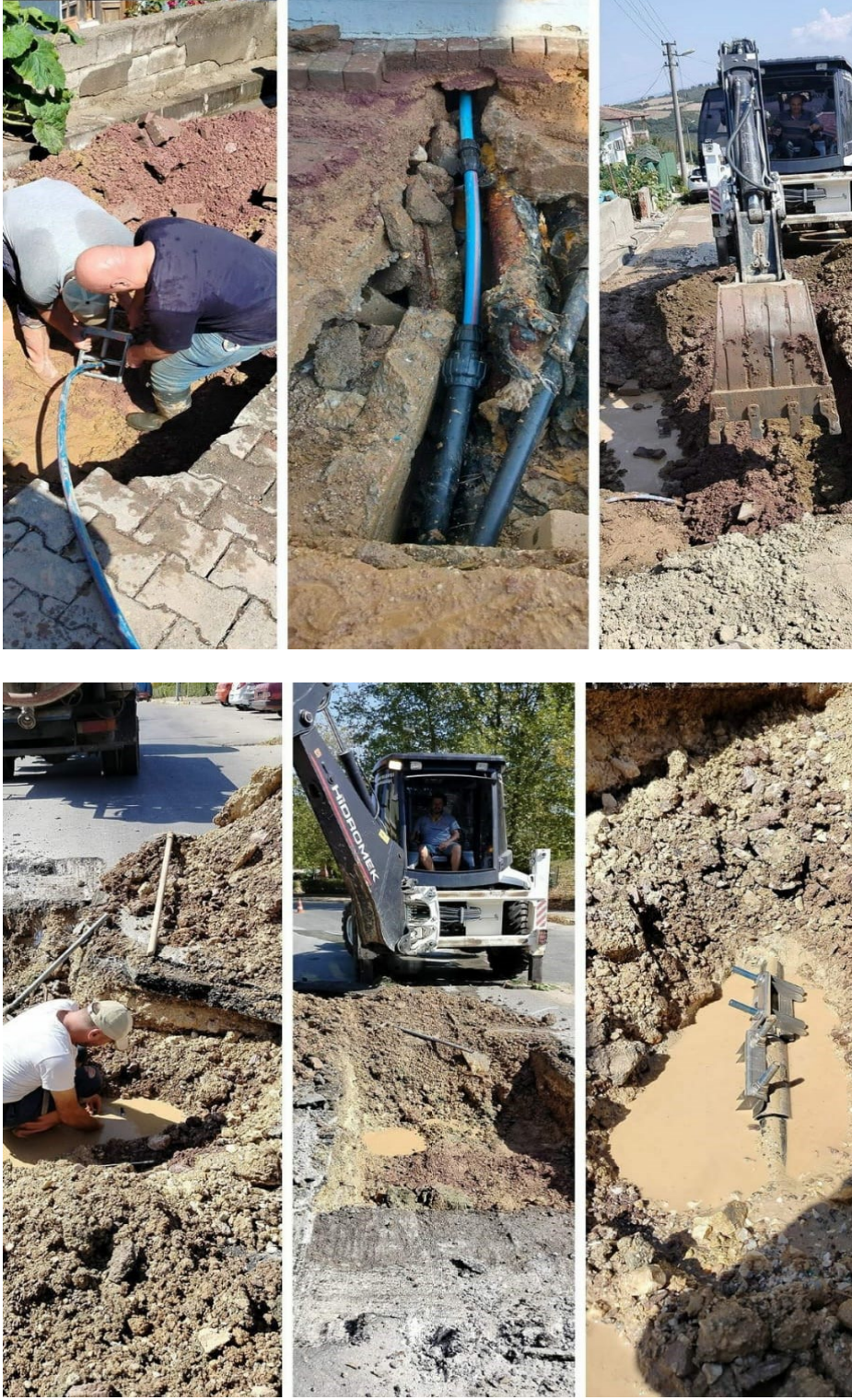
Meydana gelen su kaçaqlarının onarımı gerekleřtirildi.
