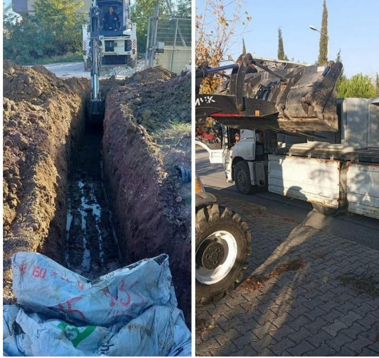
İhtiyaç duyulan bölgelerde kanalizasyon alt yapısı çalıřmaları tamamlandı.
