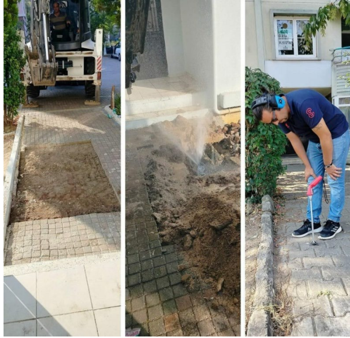
Su kaçaqları, dinleme cihazımız sayesinde tespit edilerek çözümü kolaylıkla sağlandı.
