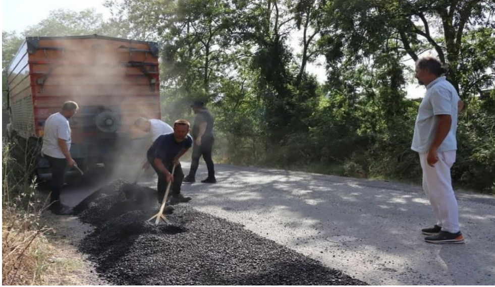
Subaşı Beldesi Merkez Mahallesi okul yanı mevkiinde asfalt onarım alıřmaları yapıldı.
