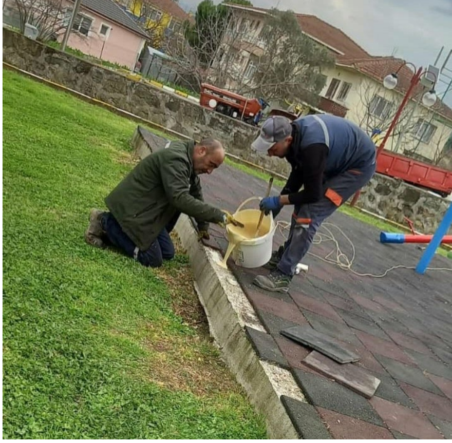
Merkez Mahallesiindeki oyun parkında yumuřak zeminlerin onarımı yapıldı.
