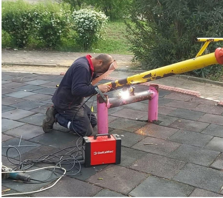
Oyun parklarımızda bakım onarım çalıřmaları yapıldı.
