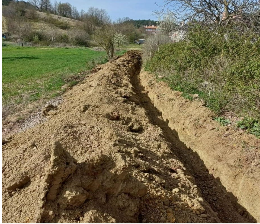
Karaçamur Mevkiinden 700 metre içme suyu hattı yapıldı.
