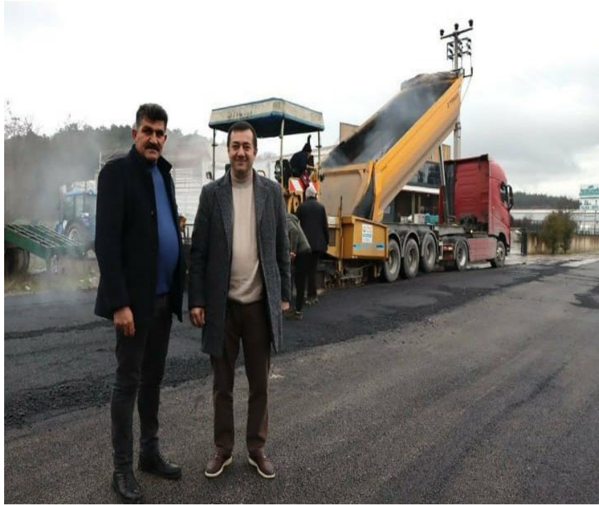
Kemerköprü Caddesinde asfalt serimi çalışması yapıldı.
